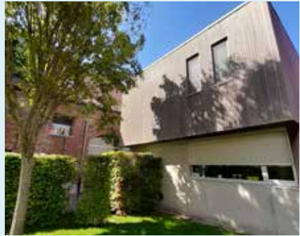
Bomen, struiken en planten zorgen voor verkoeling door schaduw en verdamping.
