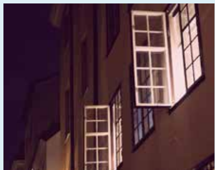
Zet je ramen open zodra het buiten frisser is dan binnen om je huis af te koelen.
